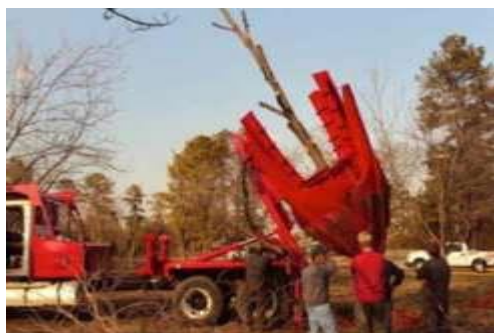
90AG – Kiemelés közben
